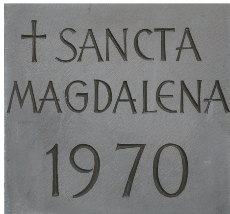
Am Kirchturm angebrachter Hinweis auf das Jahr der Grundsteinlegung für unsere neue Pfarrkirche
